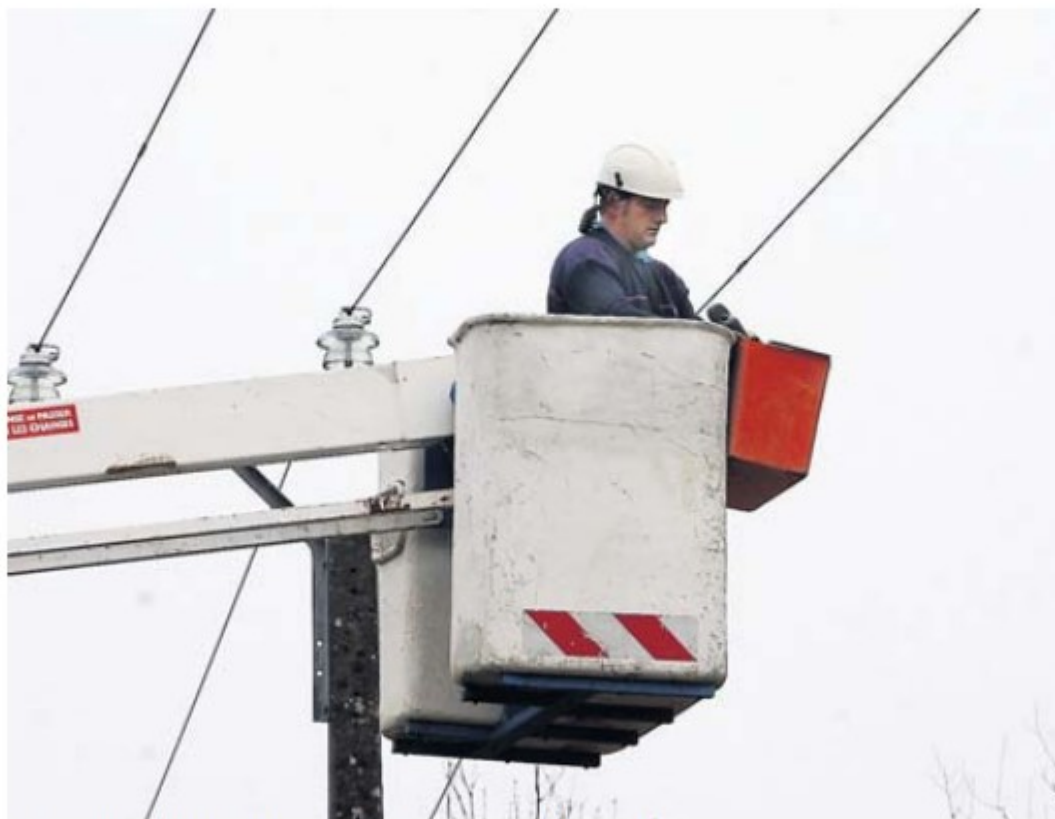
La rénovation et la réhabilitation des équipements s'achèveront à l'horizon 2020. / Photo archives DDM Laurent Dard.
